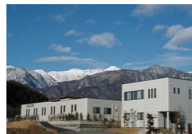
株式会社ヨシオカ駒ヶ根工場
